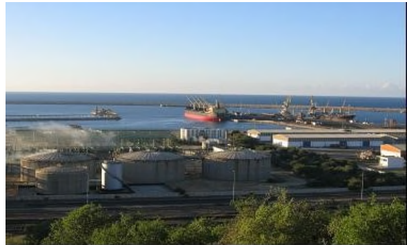
OCP - Port de Jorf Lafsar
