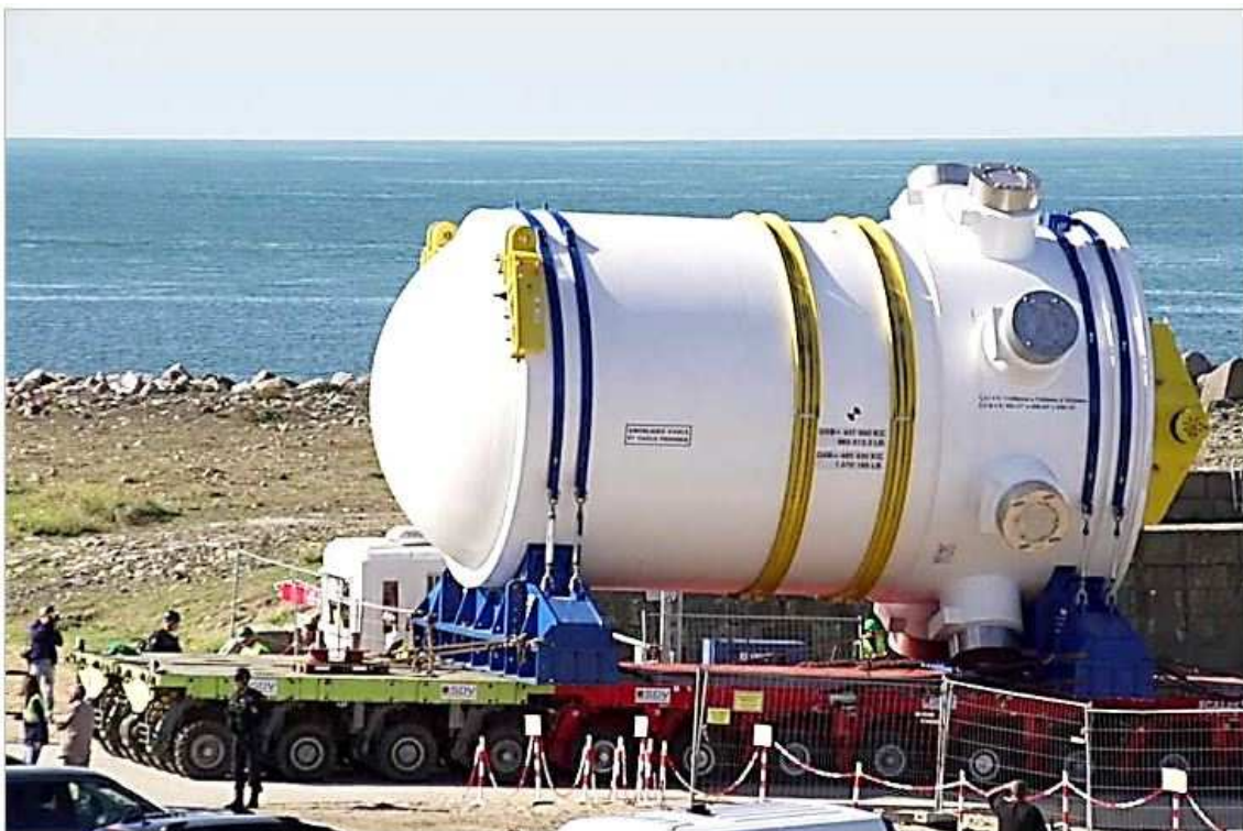
Arrivée de la cuve de l'EPR (European Pressure Reactor) sur le site de Flamanville
