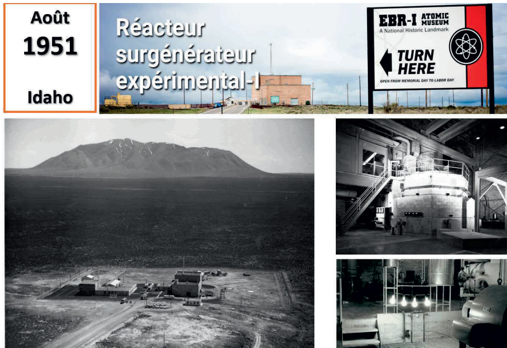
Figure 8 : EBR1, le premier réacteur civil au monde était un RNR refroidi au sodium (NaK)
