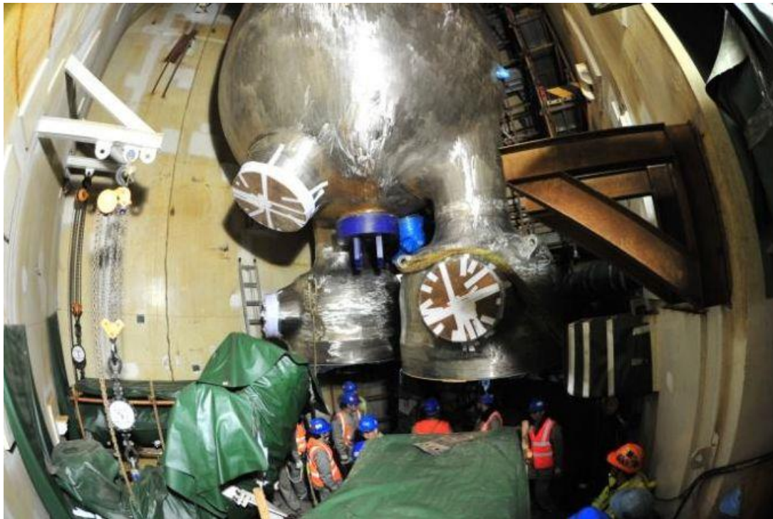
Vue de l'environnement sous le GV là où les pompes seront fixées
