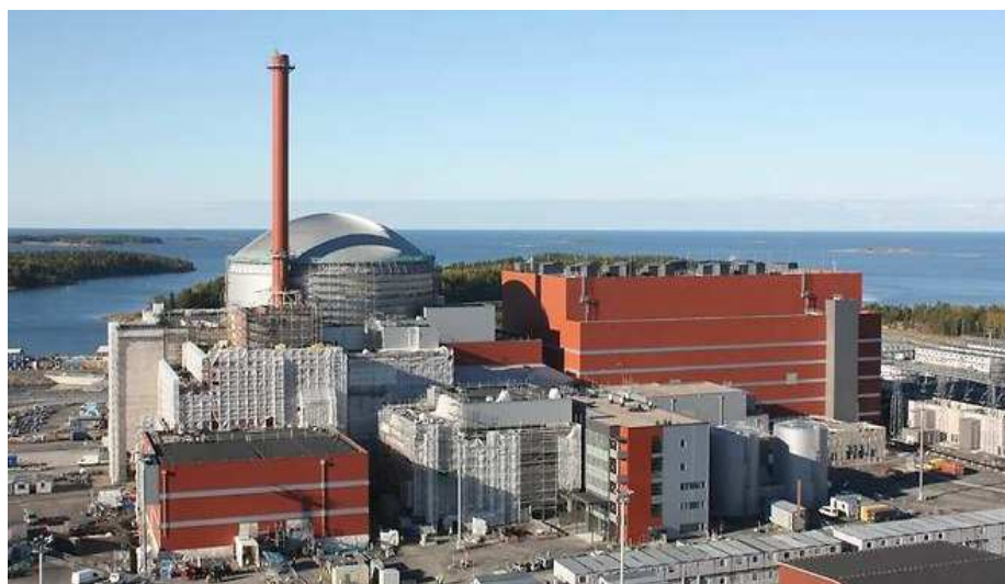
Le chantier du réacteur EPR d' Olkiluoto (Finlande). - Areva
